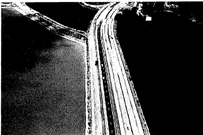
Figura 4.1 A Barragem Anchieta separa o braço do Rio Grande do restante da Billings (dezembro de 1999). Fonte: CAPOBIANCO & WHATELY (2002)
