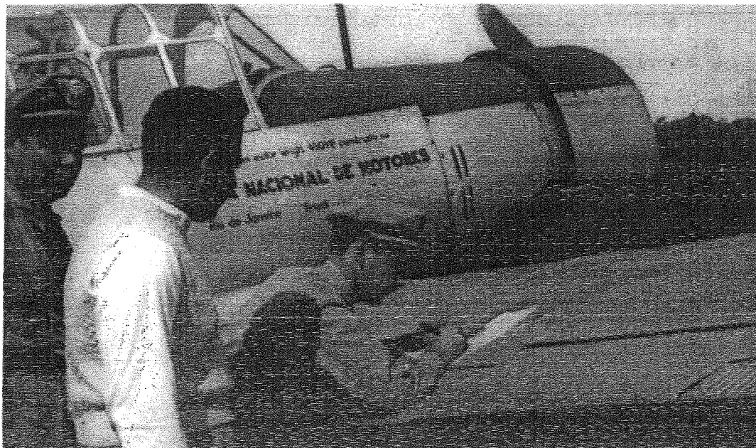
Figura 4.13: Avião Vultee BT-15, equipado com motor FNM – Wright Whirlwind de 450 HP, fabricado na FNM, fazendo últimos ajustes antes de levantar vôo. (Arquivo Lauter Nogueira).
