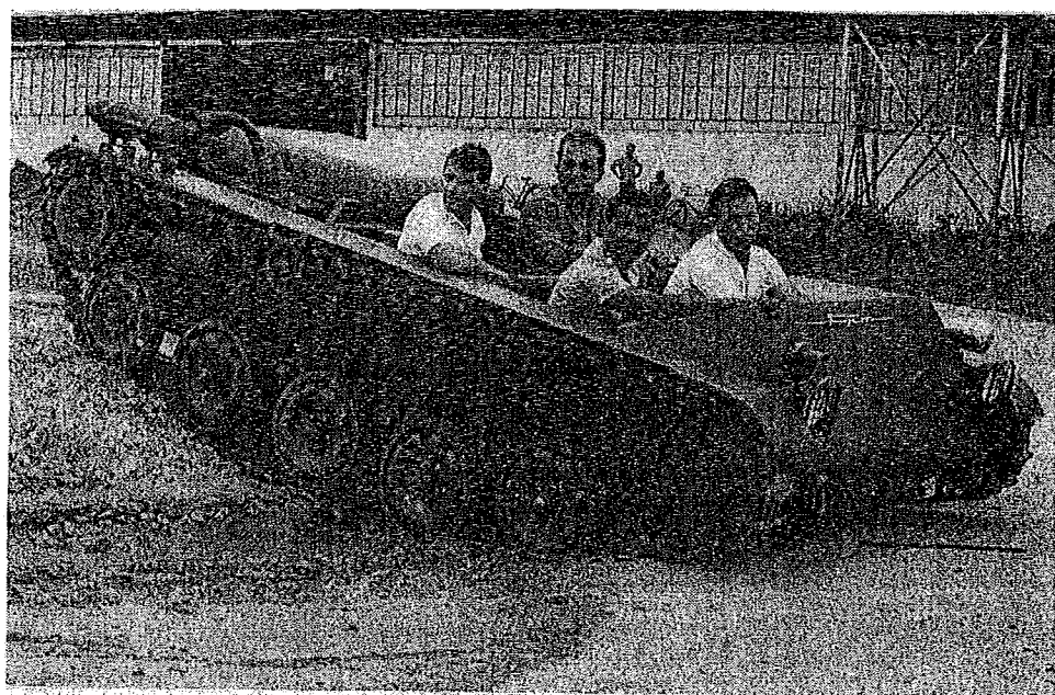
Figura F.2: Blindado sobre lagartas saindo da serralheria da FNM para primeiros testes em Novembro de 1965 ( Arquivo Castro Silva)
