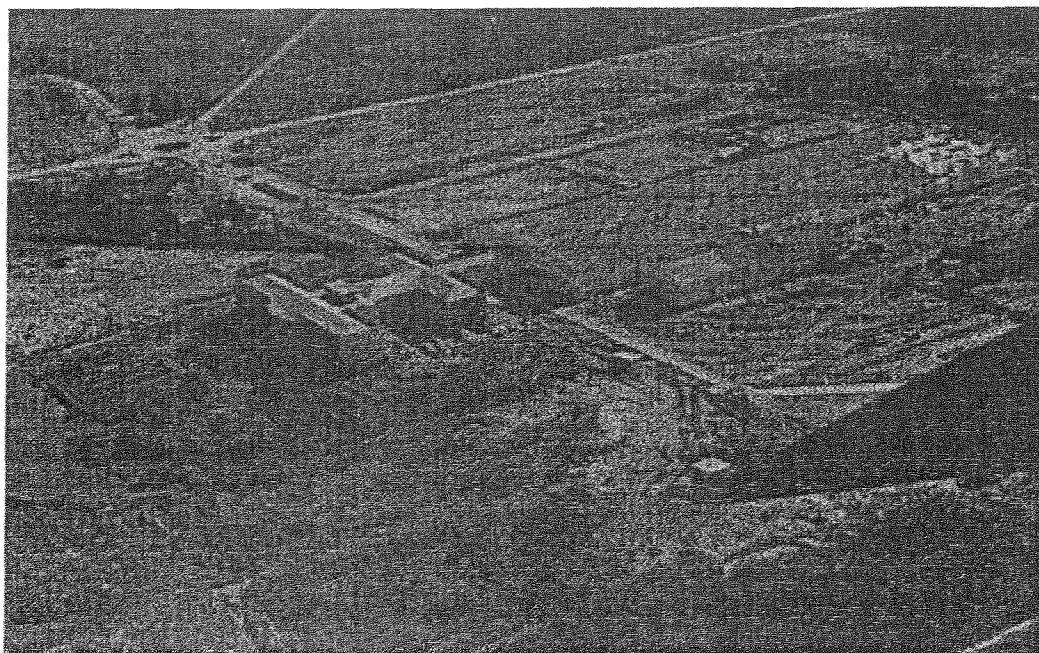
Figura 4.18: Os prédios da FNM em construção com destaque para o pavilhão de máquinas, ao centro. (O OBSERVADOR, 1946)
