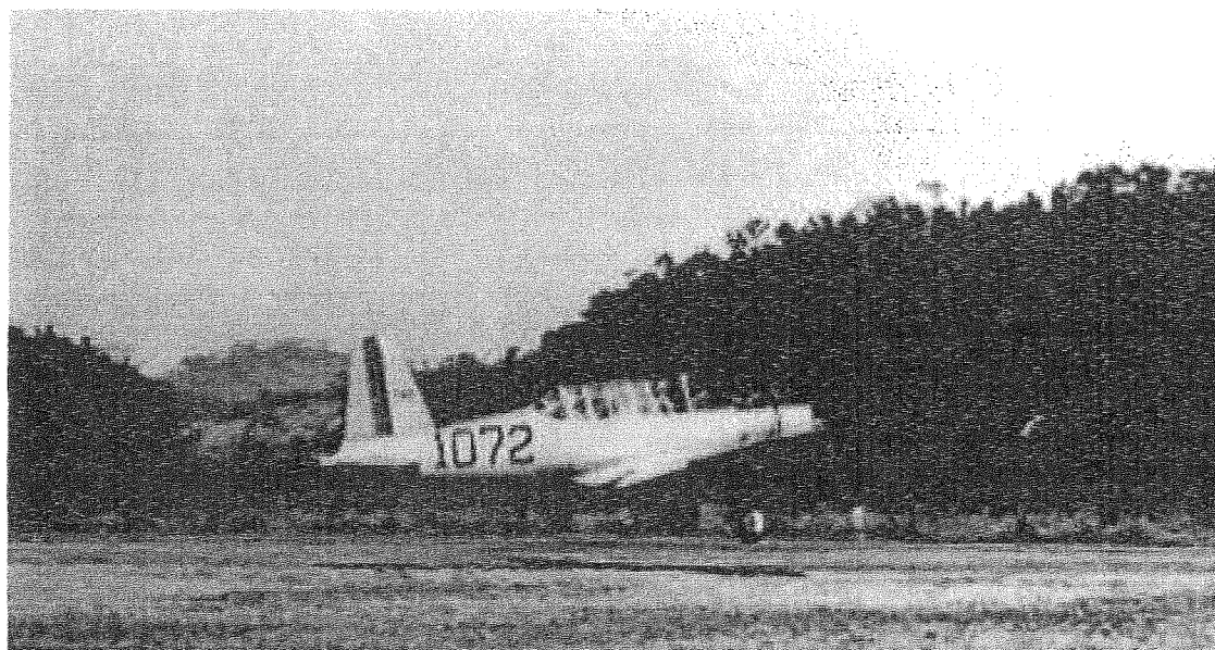
Figura 4.14: Avião Vultee BT-15 (Vultee Valiant ou Vultee Vibrator) da FAB decolando com motor FNM-Wright Whirlwind de 450 HP, em 19 de Agosto de 1946. ( Disponível Internet http://www.nascente.com.br/enciclop/cap002/032.htm . Consultado em 30/08/2004)
