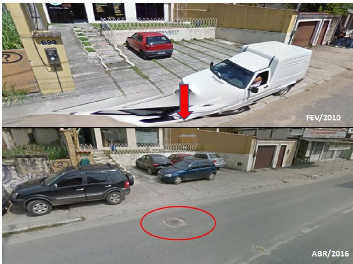
Figura 39: Bueiro com desnível
