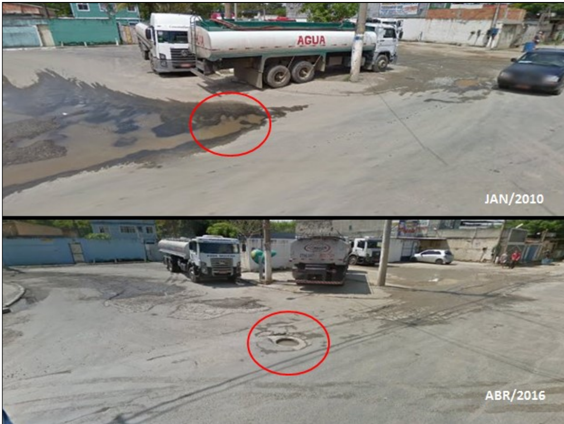
Figura 43: Caso de bueiro sem tampa
