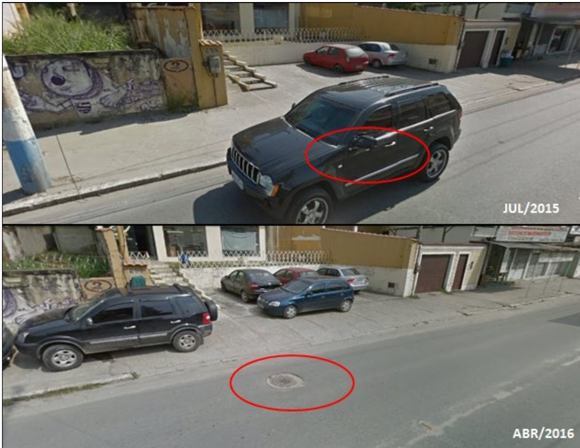
Figura 41: Caso de bueiro com desnível
