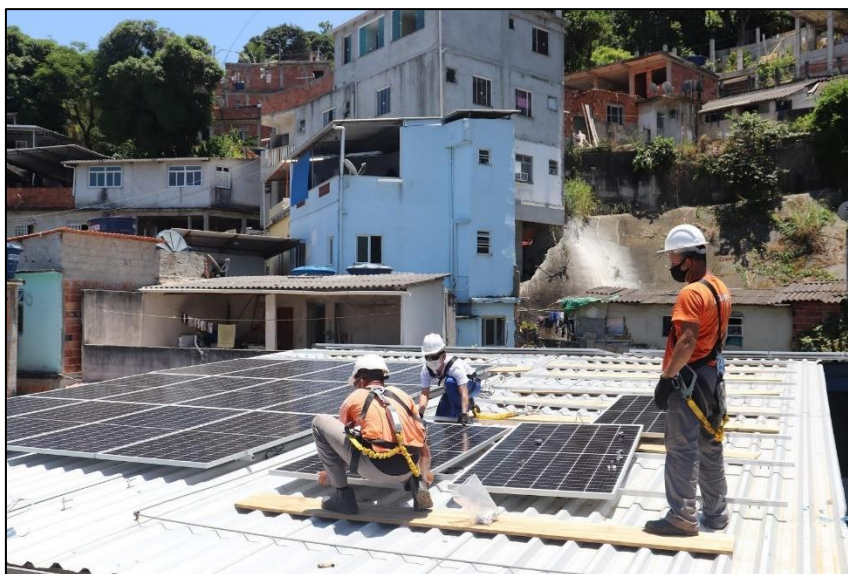
Figura 51. Instalação das placas solares do telhado da Associação de Moradores, 18/02/2021 (Acervo Revolusolar)
